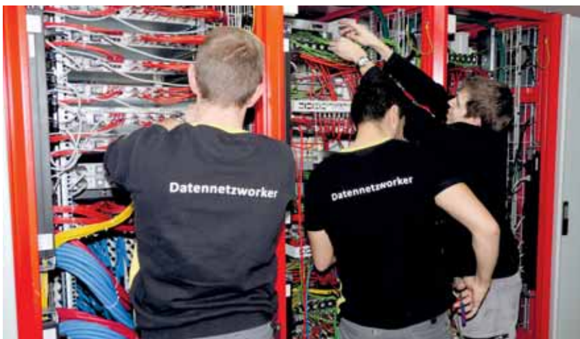
Infra-Com Swiss-Mitarbeiter bei den nächtlichen Migrationsarbeiten
